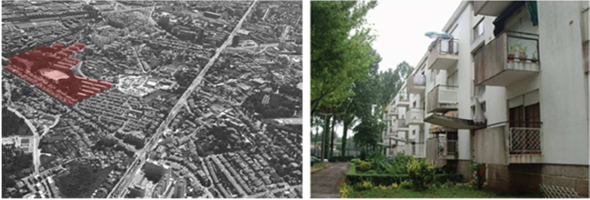
Fig. 5 - Intervenção em Ramalde, localização no google maps .
